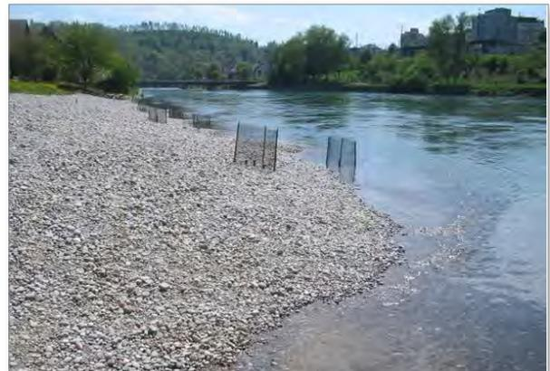
**Abbildung 28:** Abflachung und Strukturierung der Ufer unterhalb der Rheinhalde in Gailingen (links) sowie in Flurlingen oberhalb der Neuhauserstrasse (rechts). Fotos: WFN.
